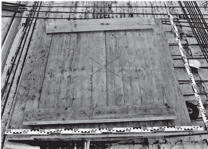
Abb.: Rekonstruktion der Schaltafelabdeckung durch die Polizei (act. 22/13, Foto Nr. 11)
